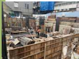
▲地下室牆、柱模板組立
